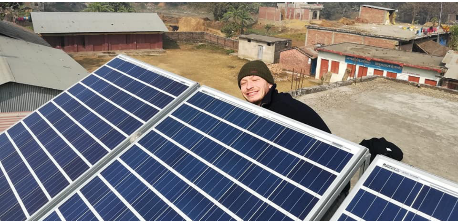
Installation der Photovoltaikanlagen auf dem Dach des Wasserzentrums
